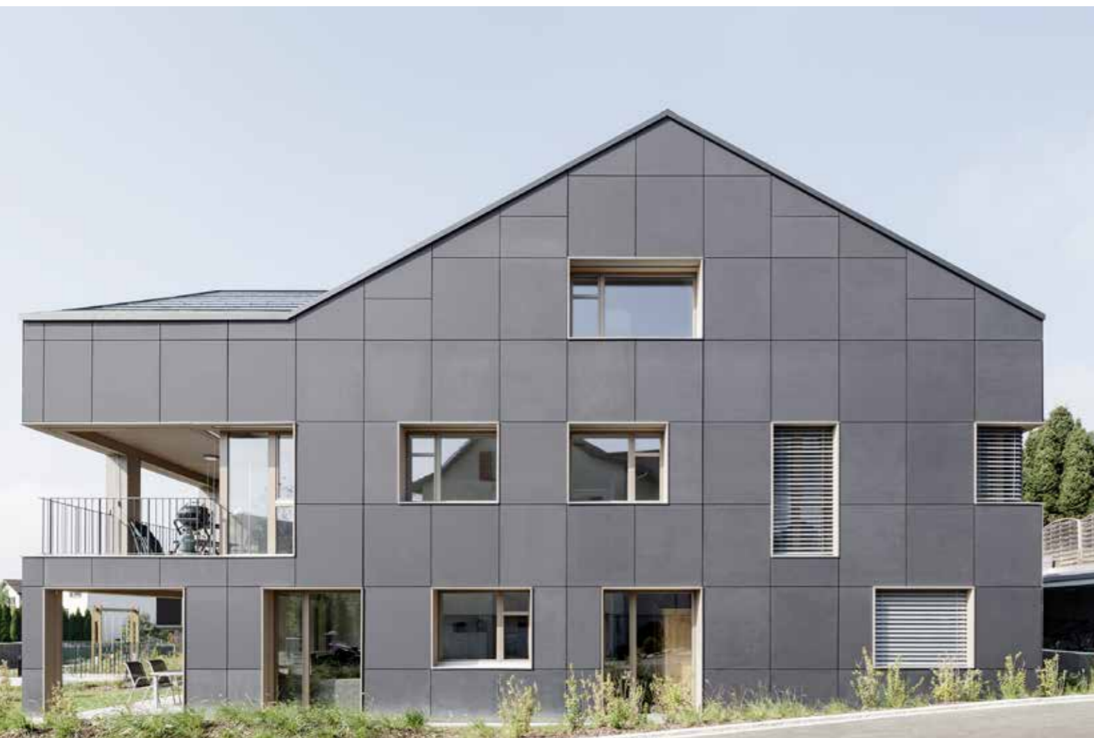
Erstes energieautarkes Mehrfamilienhaus der Welt - ein Projekt der Umwelt Arena Schweiz und smartwindows.
